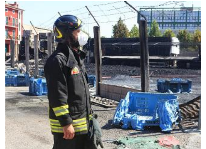
I danni provocati dal recente incendio nella ZAI di Verona
