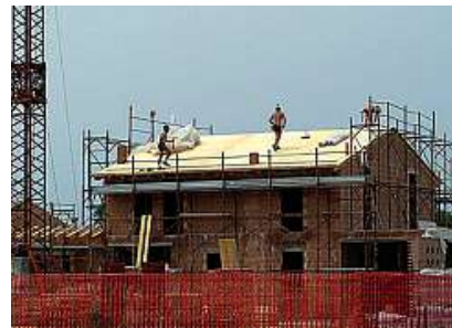
Lavorare in quota richiede massima attenzione alla sicurezza
