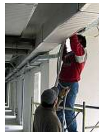
Lavori in un impianto elettrico
