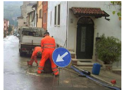
Operai al lavoro per sistemare una strada
